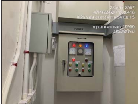
รูปที่ 5 มิเตอร์ไฟฟ้าสำหรับน้ำเสีย
